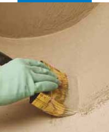
Hidroizolarea unei terase aplicând materialul cu bidineaua
